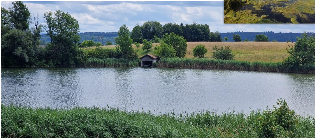
Bellacher Weiher nach Abschluss der Sanierung (2024)
